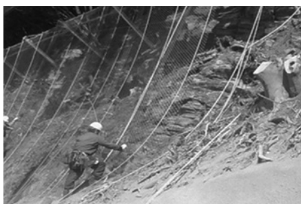
図2.20 魚網・ネットによる浮石止め
