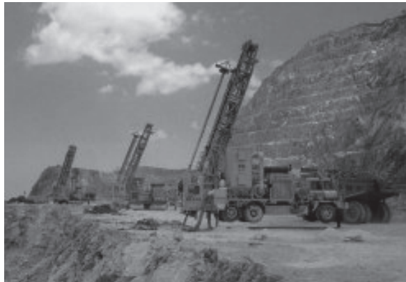
発破孔のせん孔作業
