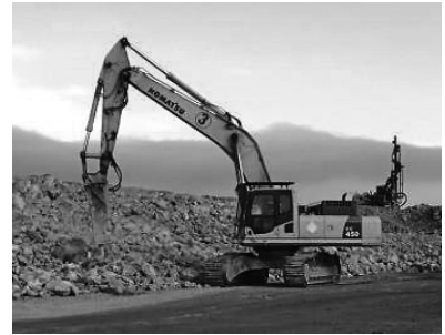
図2.18 ブレーカ工法
