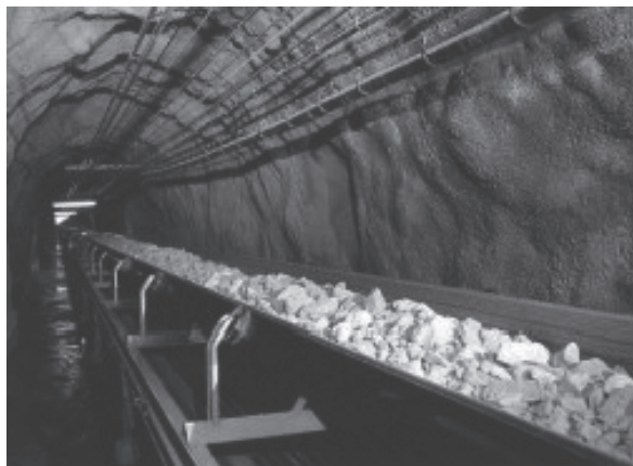
石灰石輸送用ベルトコンベア
