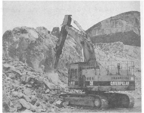
図 1.20 ブレーカ工法
