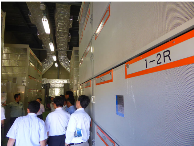
離島マイクログリッド見学(写真はNaS電池) 沖縄県宮古島(現地環境委員会)
